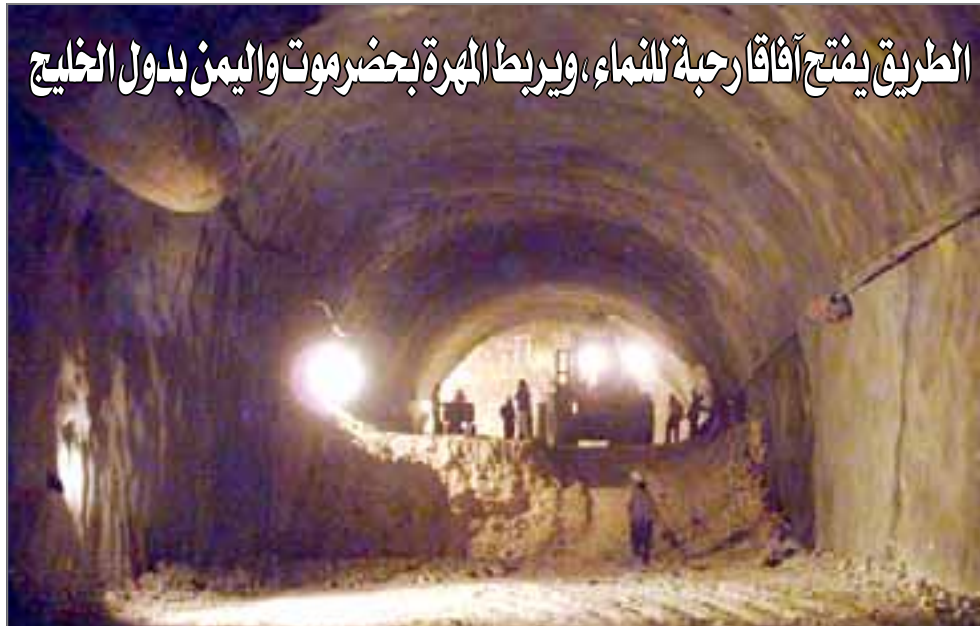
منظر للنفق من الداخل
