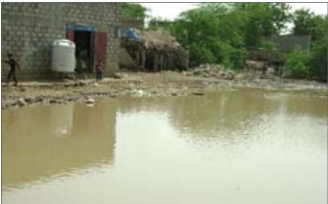
هو ذلك عمل يبدو للوهلة الأولى أنه غير قابل للخراب على اعتبار أن تحمله سيظل لعشرات السنين. مشاريع الصرف الصحي إحدى هذه الأعمال التي صرفت عليها ملايين الدولارات في أمانة العاصمة، والنتيجة مشاكل بدأت تظهر بعد سنتين فقط من انتهاء المشروع. عبد الناصر الهاللي
