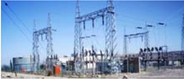
الكهربائية (١٧) في مديريات تعز خلال الفترة الموضحة بعالية هي (٨) مشاريع وأن (٩) مشاريع جاري العمل بها ويوشك على الانتهاء منها منوها أن المشاريع المستكملة هي مشاريع كهرباء الأحكام، قديس، المقاطرة، العدة، التبشاشية، النجادة، مخلاف أسفل
